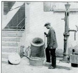
Fig. 7. — Installation ménagère chez un cultivateur de Zellwiller (Bas-Rhin). Près de la pompe à main, on distingue le tuyau de sorte d'une conduite d'eau alimentée par une pompe électrique.
