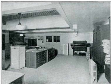
Fig. 4. — Bureau d'archives chauffé au moyen de poêles à accumulation et de radiateurs directs d'appoint.
