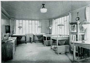
Fig. 1. — Salle d'assemblage de clichés photographiques. A noter la facilité avec laquelle on peut modifier l'emplacement et le nombre des radiateurs.
