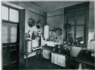
Fig. 4. — Cuisine électrique complète installée chez un cultivateur à Ebersheim (Bas-Rhin). On distingue en partant de gauche, l'Electro-Economique, un réchaud à 2 plaques et un chauffe-eau de 50 litres; l'eau est fournie par une pompe électrique.
