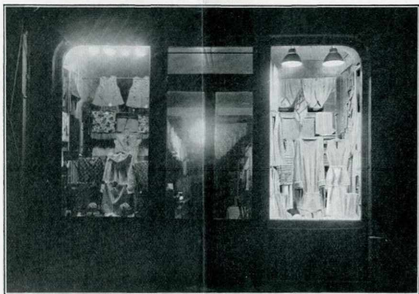
Fig. 1. — Petites vitrines, à gauche, ancienne installation avec un éclairage de 85 lux; à droite, installation pendant l'essai avec 1 000 lux.
